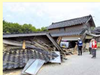
現地調査風景
