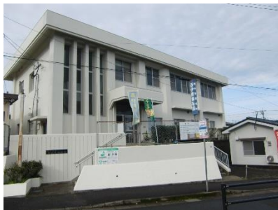
外壁改修が完了
