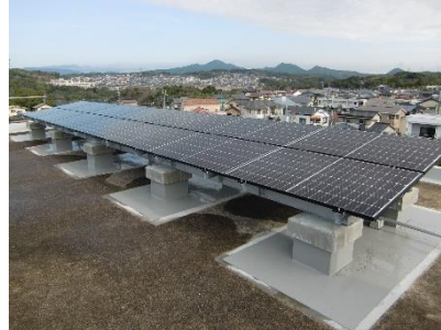
太陽光発電パネルの設置（福祉館屋上）
